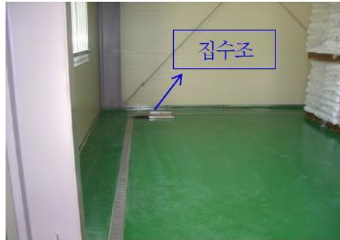
배수로 및 집수조 설치
