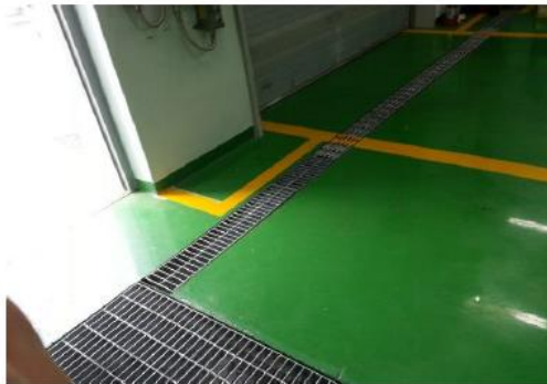
바닥코팅 및 배수로
